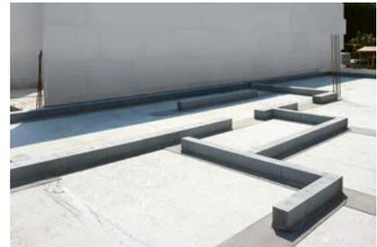
Die fertige Kimmschicht erlaubt einen Eindruck vom Grundriss und bietet den planebenen Untergrund für das weitere Mauerwerk.
