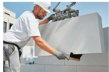
Vor dem Absetzen des Elements auf der Lagerfuge wird die Steinunterseite abgefegt, um eine kraftschlüssige Verbindung zu gewährleisten.
