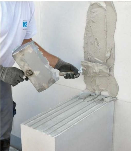
Für das Aufmauern der Querwand wird ausreichend Dünnbettmörtel für den Stumpfstoß aufgezogen.
