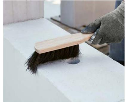
Vor dem Auftragen des Mörtels Lagerfugen abfegen und ggf. vorzässen, um eine kraftschlüssige Verbindung zu gewährleisten.
