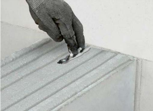
Die Flachanker werden nun heruntergebogen, satt in die nächste Lagerfuge eingelegt und anschließend vollflächig satt und kraftschlüssig vermörtelt.
