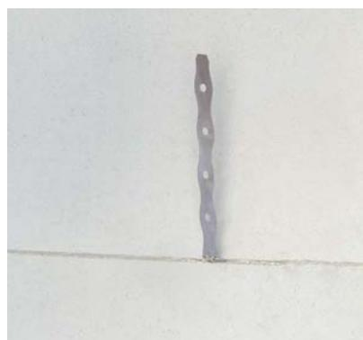
Der hervorstehende Teil des Flachankers sollte bis zur endgültigen Verbindung abgewinkelt werden, um die Arbeitssicherheit zu gewährleisten.
