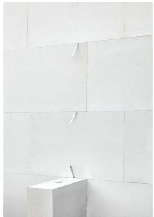
Regelmäßig eingelegte Flachanker schaffen eine stabile Verbindung zwischen den beiden Wänden.
