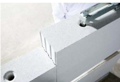
Die Regelemente sind an den Stirnflächen mit einem Nut-Feder-System versehen und werden knirsch versetzt.
