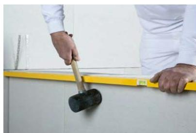
Nach dem Versetzen werden die Elemente mit einem rückschlagfreien Hammer, etwa einem Simplexhammer, ausjustiert.
