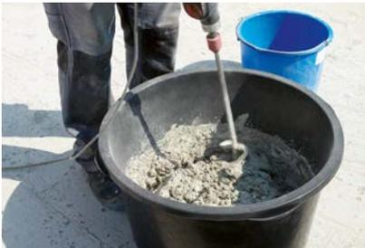
Normalmauermörtel für die Kimmschicht gemäß Herstellerangaben anmischen.
