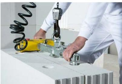
Die Versetzzange des Minikrans greift in die Hantierlöcher auf der Oberseite der Regelemente und ermöglicht so das maschinelle Versetzen.
