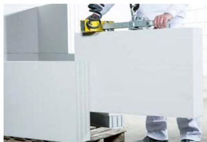
Die maßgenauen Panelemente werden exakt nach den Angaben in den Verlegeplänen versetzt.
