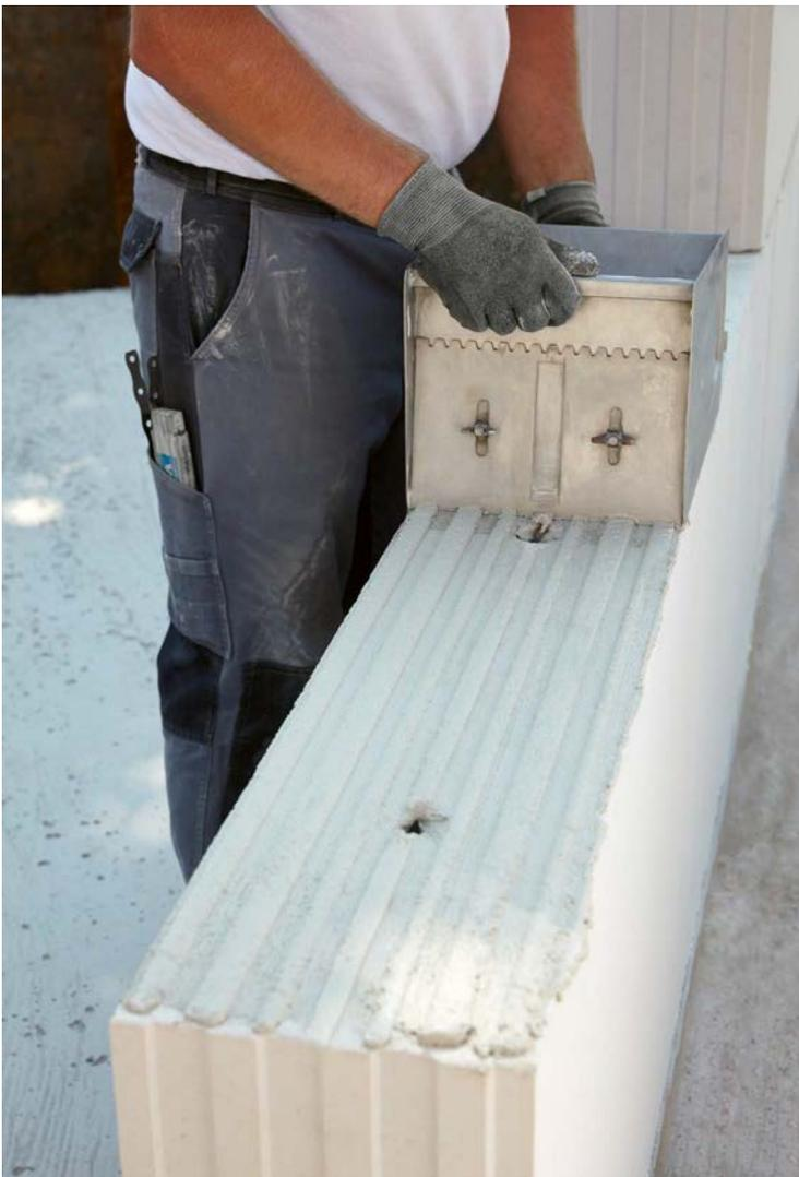
Ein gleichmäßiger Mörtelauftrag von mindestens 3 bis 4 mm Höhe ist die Voraussetzung für ein fachgerechtes Mauerwerk.
