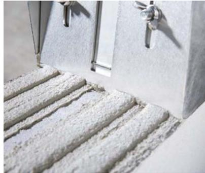
Ein strukturierter Mörtelauftrag entsteht durch die richtige Zahnschiene und eine Mörtelschlittenbreite, die exakt auf die Steindicke abgestimmt ist.
