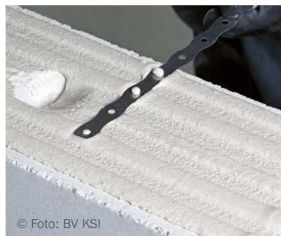
Einlegen des Flachankers in der zuerst erstellten Wand in den Dünnbettmörtel.
