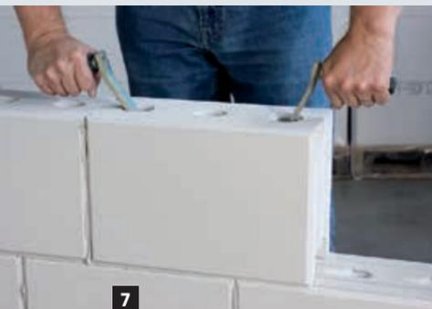
7 Handversetzung des Steins mit Griffhilfen.
