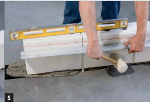
5 Ausrichten der Lage mit Setzlatte.
