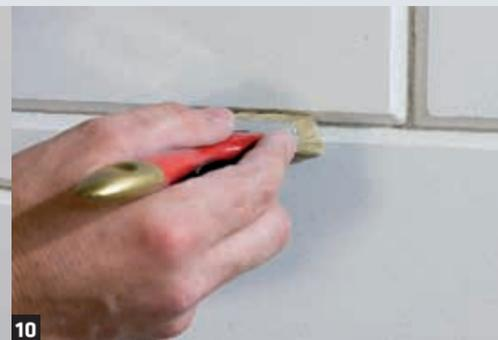
10 Die Mörtelfugen werden mit einem trockenen Pinsel nachgearbeitet.
