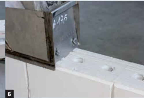
6 Aufziehen des Dünnbettmörtels mit dem Fasenstein-Mörtelschlitten.
