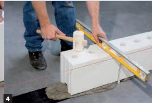
4 Ausrichten des Steins mit Gummihammer und Wasserwaage.
