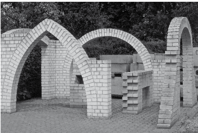
Bild 1.1: Kalksandsteine sind nicht nur Tragelement, sondern auch Gestaltungselement.
