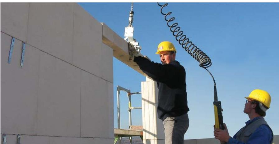
Bild 16: Einbau eines KS-Flachsturzes mit Versetzhilfe.
