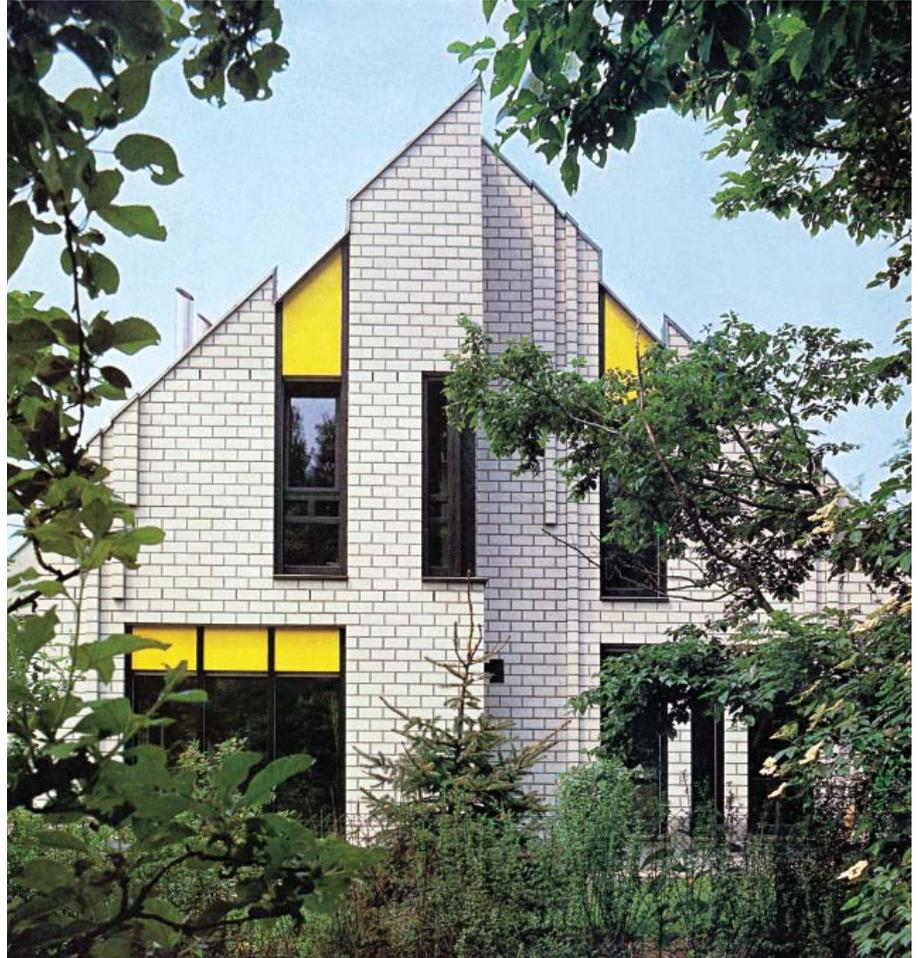
Bild 1: KS-Sichtmauerwerk-Fassade mit eingebauten KS-Sichtmauerstürzen.
