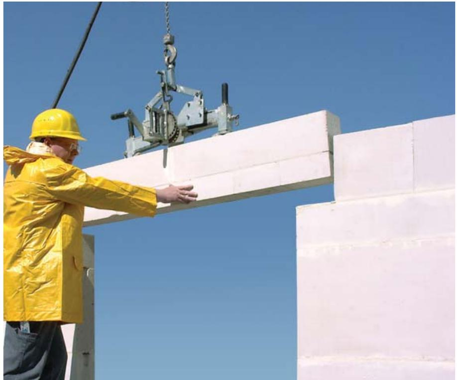
Bild 21: Einbau eines KS-Fertigteilsturzes (FTS) nach abZ Z-17.1-774.
