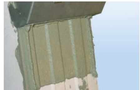
Bild 18: Stoßfugenvermörtelung mit einer geeigneten Stoßfugenkelle.
