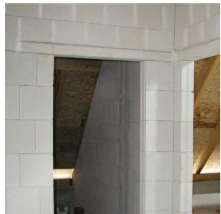
Bild 19: KS-Flachsturz mit vermörtelten Stoßfugen in der Übermauerung (Druckzone).
