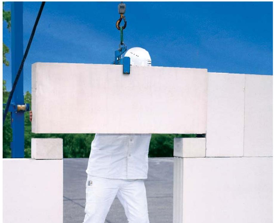
Bild 22: Einbau eines KS-Fertigteilsturzes (FTS) nach abZ Z-17.1-621.
