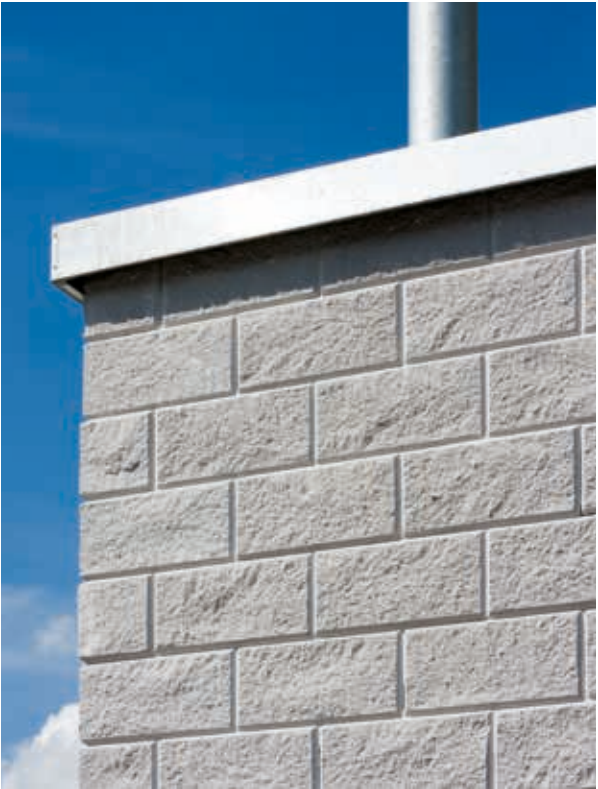
Betriebsgebäude Engelsbrand Architekturbüro: Binder Architekten, Engelsbrand © Dipl.-Ing. Stefan Witte, Neustadt an der Weinstraße
