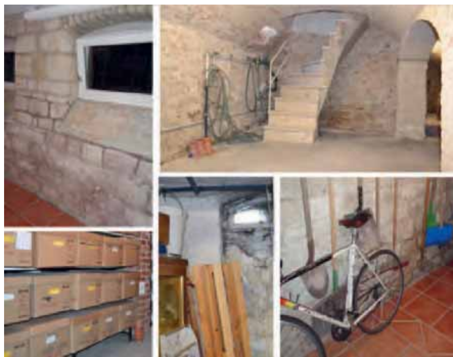
Bild 7 Beispiele für übliche Situationen in Untergeschossen historischer Gebäude ohne Abdichtungen, die regelmäßig nicht in stark durchlässigem Baugrund stehen, aber mit Ausnahme von Feuchtigkeit in den Außenbauteilen keine nennenswerten Feuchtigkeitsschäden aufweisen und sogar die Lagerung von feuchteempfindlichen Gütern zulassen
