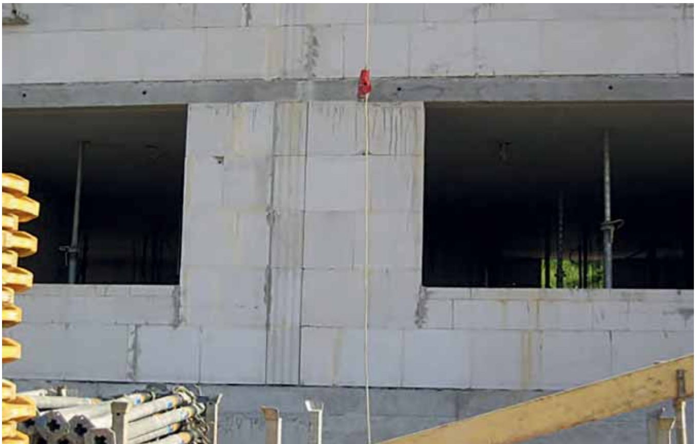
Bild 8 Durchgehende Wohnungstrennwand als Beispiel für eine optimierte schalltechnische Planung
