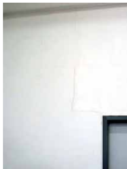
Bild 24 Rissbildung in nicht tragender Trennwand infolge Durchbiegung der unteren Geschossdecke
