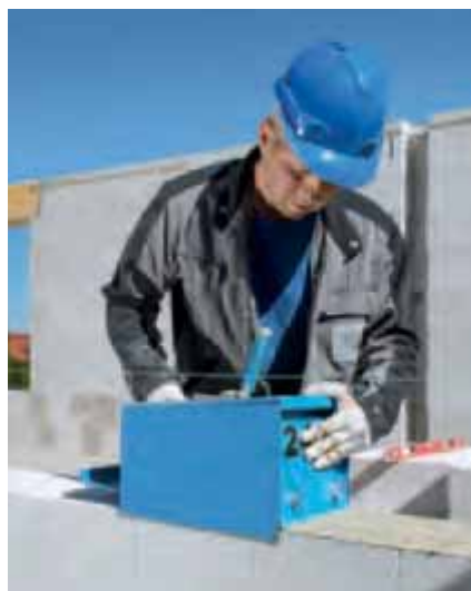
Bild 3 Dünnbettmörtelauftrag mit Mörtelschlitten
