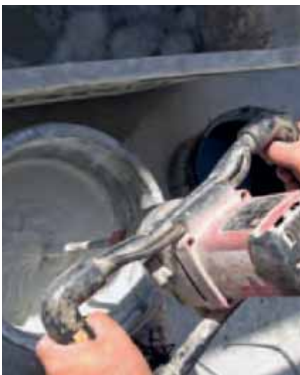
Bild 2 Anmischen von Dünnbettmörtel
