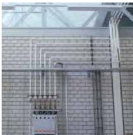
Bild 2 Innensichtmauerwerk aus Kalksandstein mit befestigten Installationsleitungen
