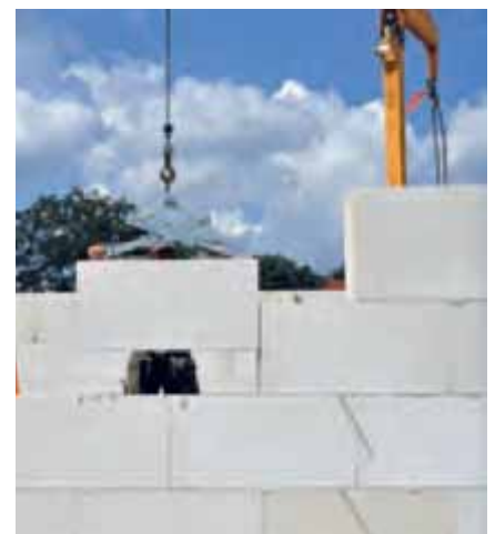
Bild 21 Maschinelles Versetzen von KS XL-Planelementen
