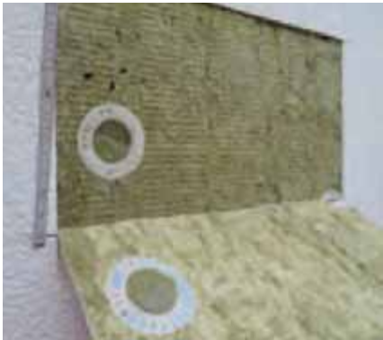
Bild 25 Versenkt eingebauter Dämmstoffdübel
