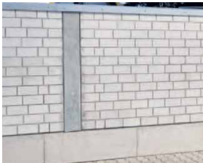
Bild 43 Freistehende KS-Wand mit horizontalen und vertikalen Aussteifungen
