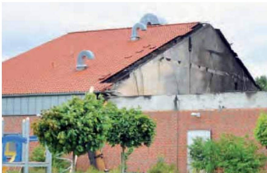
Bild 15 Eine Brandwand aus KS-Mauerwerk hat die Brandausbreitung auf weitere Gebäudeteile verhindert
