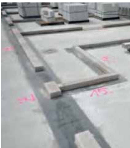
Bild 19 Anlegen der Kimmerschicht
