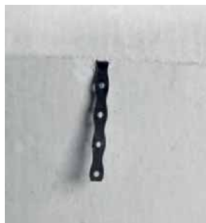
Bild 34 Stumpfstoßtechnik: Abgewinkelte Edelstahl-Flachanker (Bauphase) in Achse der anschließenden Wand
