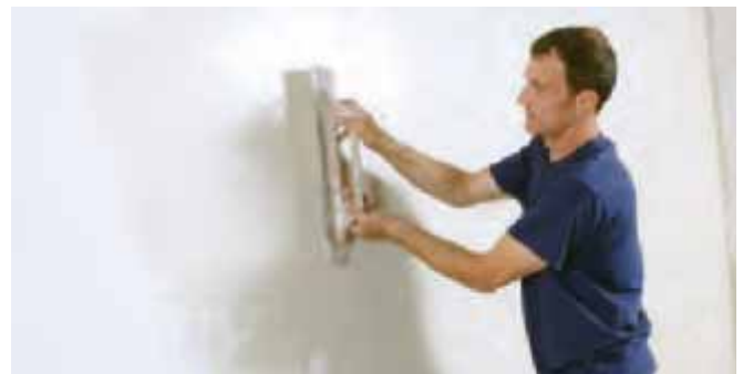
Bild 10 Arbeitsschritte beim Verputzen einer Wand; Glätten des Putzes
