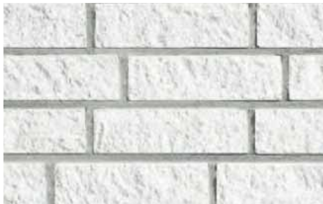
Bild 2 Sichtmauerwerk aus bruchrauen KS-Verblendern, Format NF
