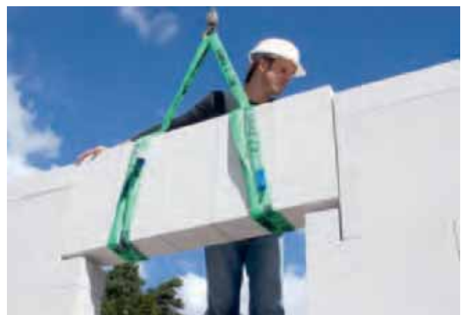
Bild 25 KS-Fertigteilstürze für großformatiges Mauerwerk
