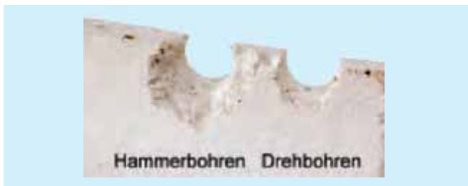
Bild 7 Unterschiedliche Vorschädigung durch Dreh- und Hammerbohren
