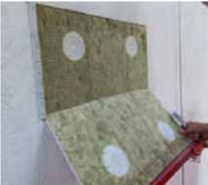
Bild 24 Oberflächenbündig eingebauter Dämmstoffdübel
