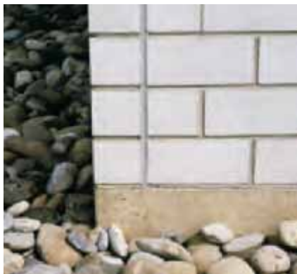
Bild 10 Dehnungsfuge an einer Gebäudeecke mit Dichtstoff verschlossen
