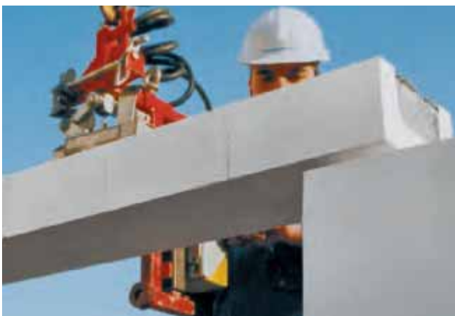
Bild 24 Vorgefertigte KS-Flachstürze zur schnellen und rationellen Öffnungsüberdeckung
