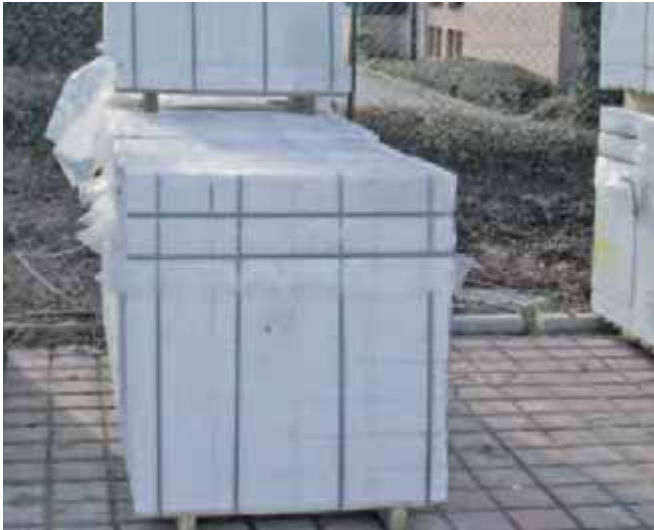
Bild 19 Lagern von Steinen mit Schutz gegen Niederschlag
