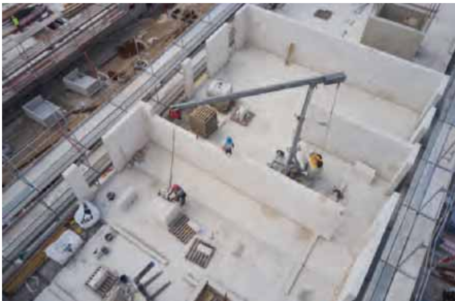
Bild 16 Modulares Bauen: hier mit KS XL
