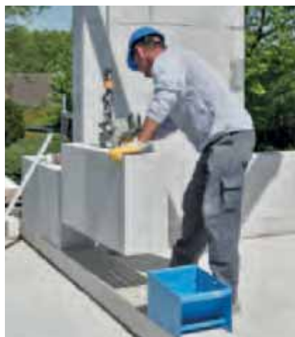
Bild 20 Versetzen von KS XL in Dünnbettmörtel
