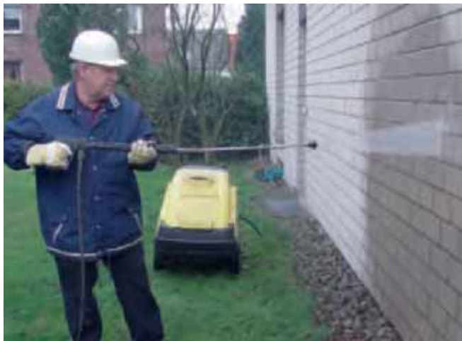
Bild 9 Reinigung mit Hochdruckreiniger und ausreichendem Abstand zum Mauerwerk
