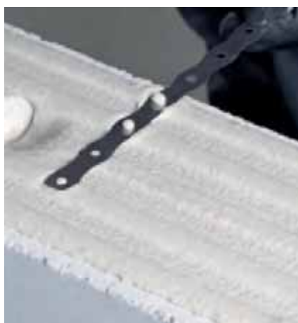
Bild 33 Stumpfstoßtechnik: Mörtelbett mit Edelstahl-Flachanker
