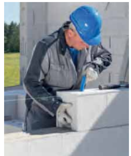
Bild 4 Versetzen von KS-R-Plansteinen in Dünnbettmörtel
