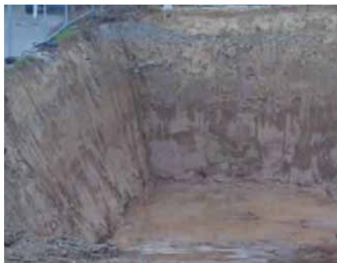
Bild 16 Beobachtungen zu Pfützen nach Niederschlägen in der offenen Baugrube sind nicht geeignet, um die späteren Beschaffenheiten bezüglich möglicher Stauwasserbildung in Arbeitsraumverfüllungen zu bestimmen.
