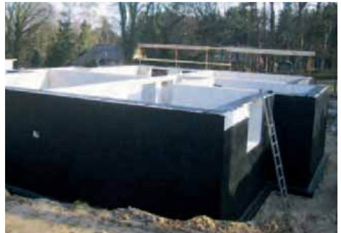
Bild 34 Kellerwand-Außenseite mit PMBC-Abdichtung
