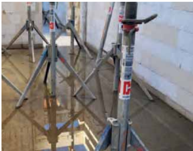
Bild 6 Erste Steinreihen werden durch Tagwasser nass, nicht durch „aufsteigende Feuchte“. Die Durchnässung beschränkt sich aber im Wesentlichen auf die erste Steinreihe
