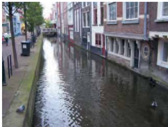
Bild 3 Historische Gebäude an einer Gracht in Delft. Die gemauerten Wände sind nur in Höhe des Wasserspiegels erkennbar nass, unmittelbar darüber aber trocken
