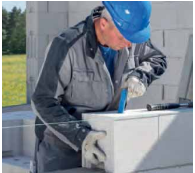
Bild 18 KS-R-Plansteine für Dünnbettmörtel
