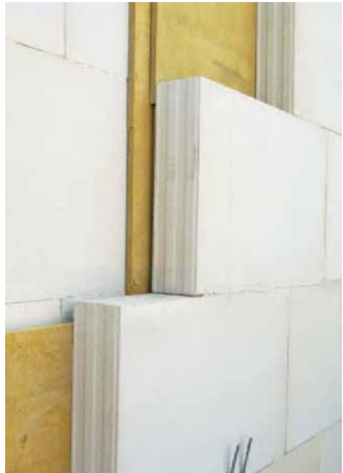
Bild 35 Dicht gestoßene Mineralfaserplatten Typ WTH vermeiden Schallbrücken
