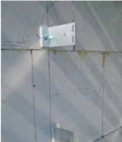
Bild 35 Vorgehängte hinterlüftete Fassaden mit Aluminium-Unterkonstruktion
