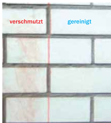
Bild 10 Reinigungseffekt, Beispiel Reinigung mit Schleifpapier, Körnung 140
